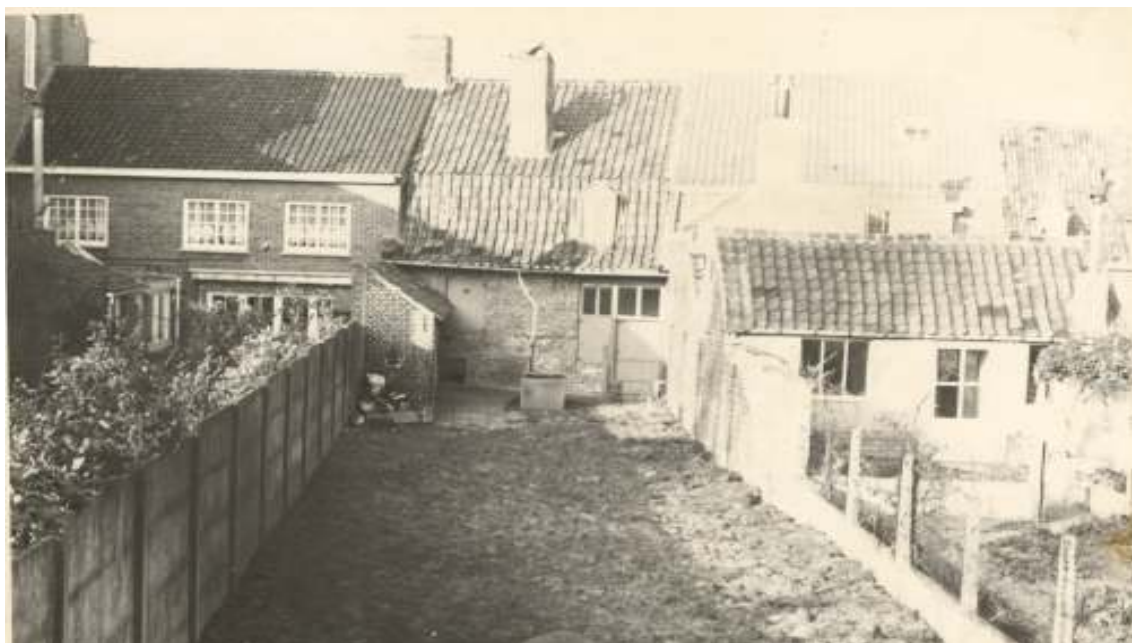
De achterkant van de beide huisjes aan de linker zijde van de oude inrijpoort zoals ze er voorheen bij lagen. Hier was nog een tijdje werkplaats Elektriciteit gevestigd.
