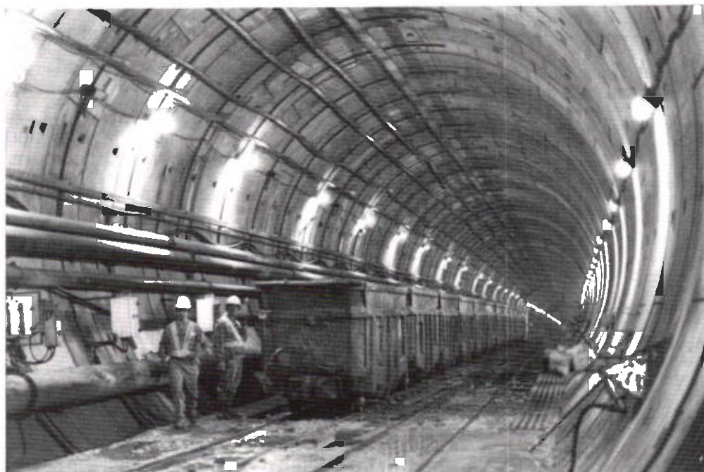
Een van de twee spoorwegtunnels in opbouw die Groot-Brittannië verbindt met het Europese vasteland.
