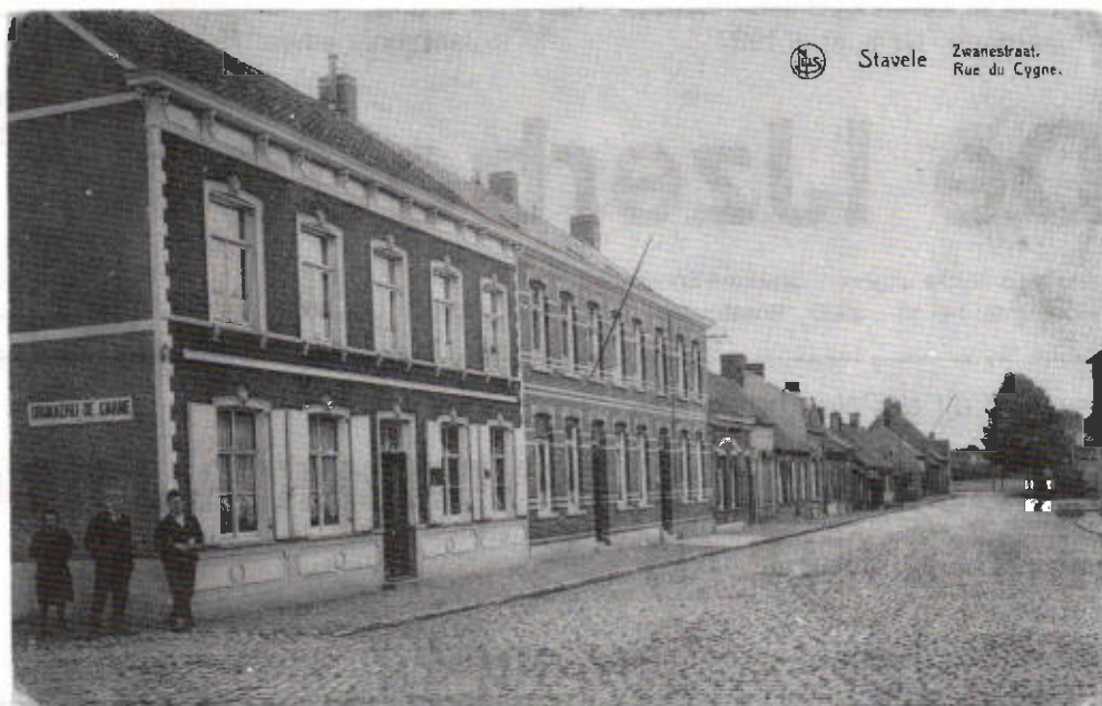
In de jaren twintig : de drie huizen De Carne Vooraan links, weg van de rooilijn - en niet te zien op de foto - lag het gebouw van de steendrukkerij (de vroegere herberg In de Kuiperij).
