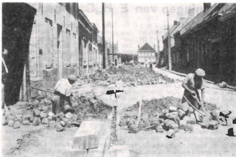
Stavele 1952. Rioleringswerken. Burgemeester Joseph Cornelis kijkt toe van uit zijn inrijpoort hoe Jordain Porreye en Raphaël Deroo in de Krombekestraat vóór zijn huis aan het werk zijn. Naar de markt toe ligt gans de straat open.
